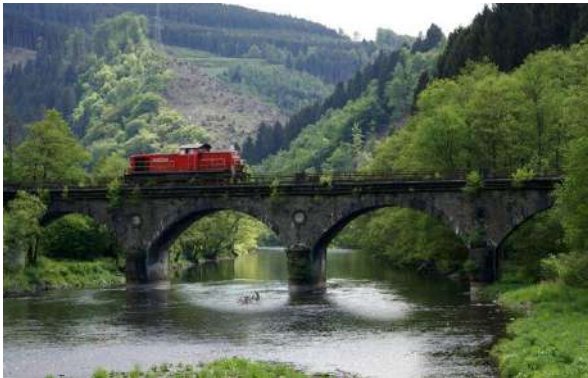
Abbildung 12: Eisenbahn-Viadukt in Werdohl-Ütterlingsen (Quelle: Heiner Burkhardt)
