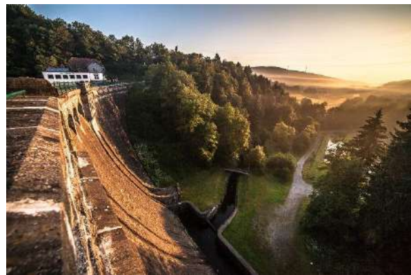
Abbildung 7: Staumauer der Oestertalsperre in Plettenberg (Quelle: KulTour GmbH)
